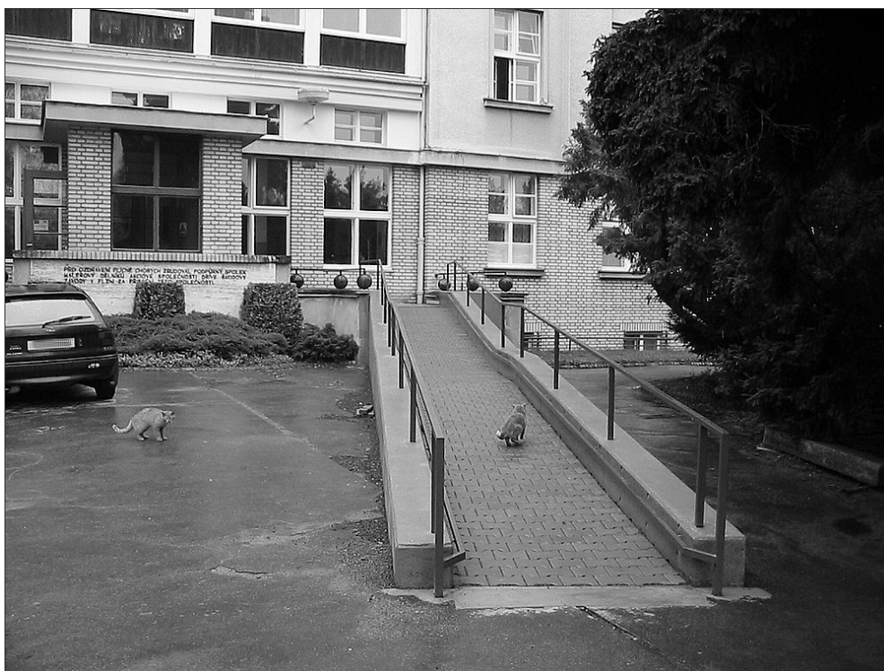
22.2 Bezbariérové úpravy - rampa
